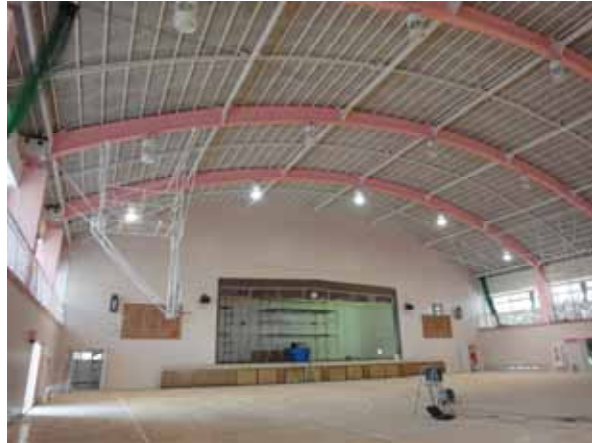
耐震化と修繕工事中の太子中学校体育館
