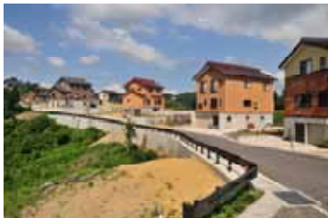
：写真 の集落ごと移転した新設住宅地
