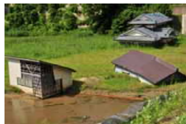
：震災で川がせき止められ埋没した住宅
